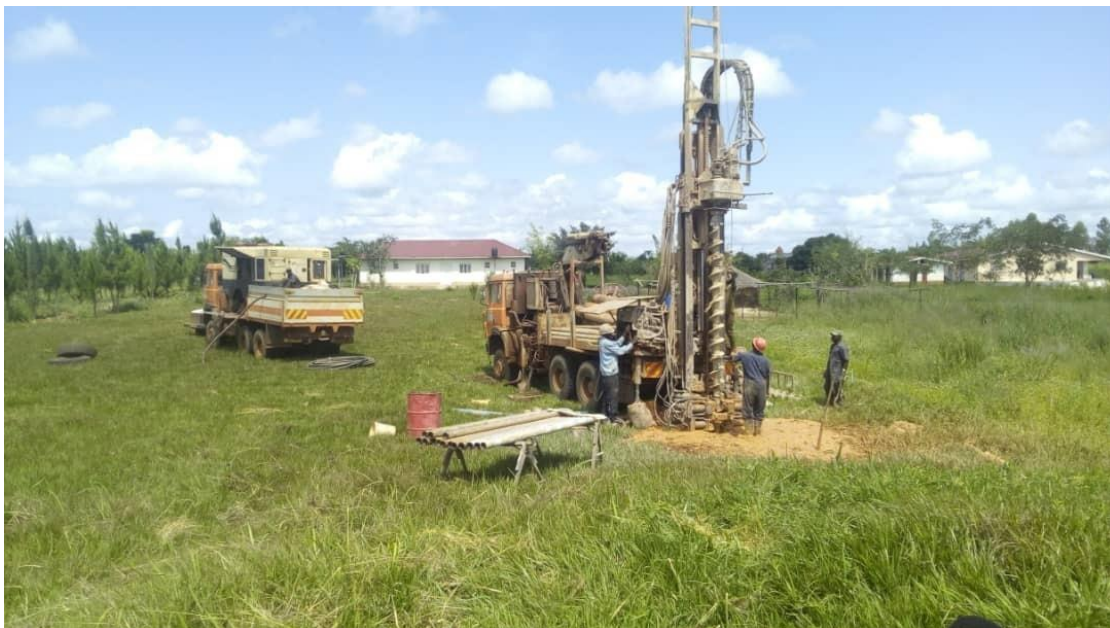
Abb. 4: Erste Bohrung für den Brunnen bei uns auf dem Gelände
